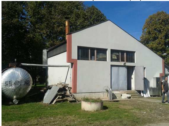
Foto: Školska kotlarnica - septembar 2014 (GIZ)
